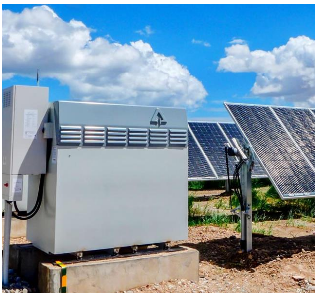
Figur 39 - Flow batteri fra Invinity fanger opp overskuddsenergi fra solcellepaneler
