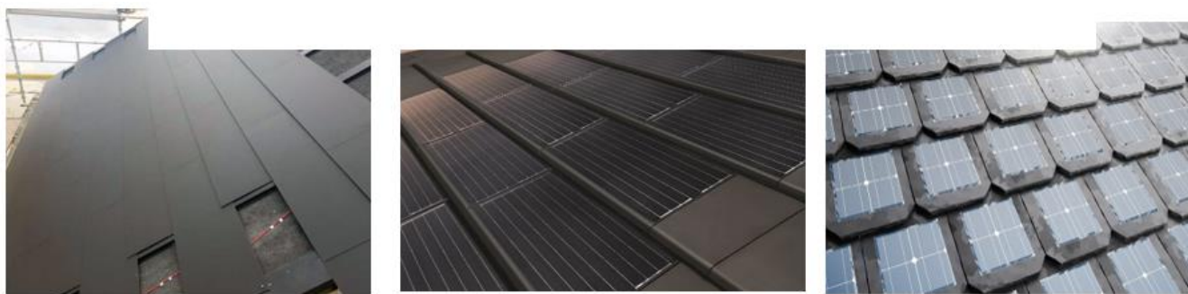
Figur 31 - Solceller på tak. Det finnes en rekke løsninger som kan monteres på tak, integreres i takstein eller fungere som bærende konstruksjon.
