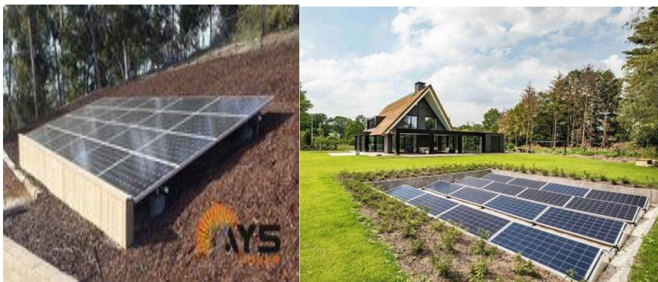
Figur 32 - Solcellepaneler kan monteres på eller mot terreng
